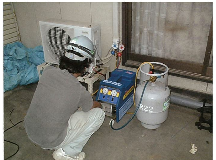
某事務所フロン回収作業
